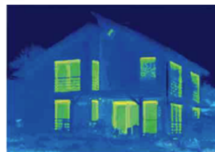
Nach dem sorgfältigen Einbau neuer Fenster aus dem Schüco Living Fenstersystem beweist die Thermografie den hohen energetischen Nutzen der Investition.
